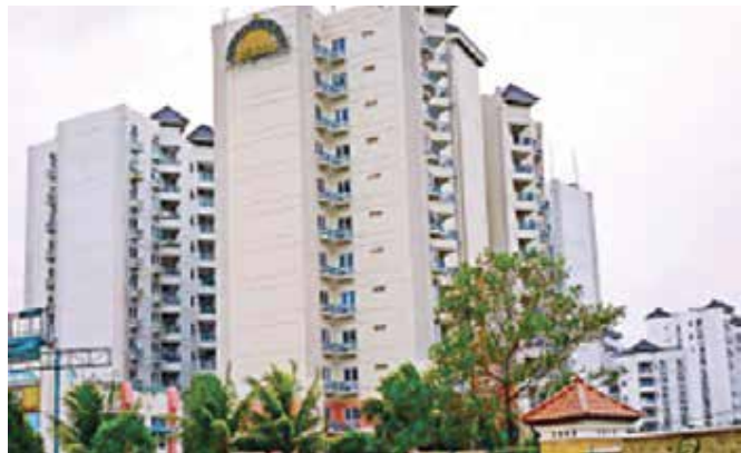
Kondominium Menara Kelapa Gading
