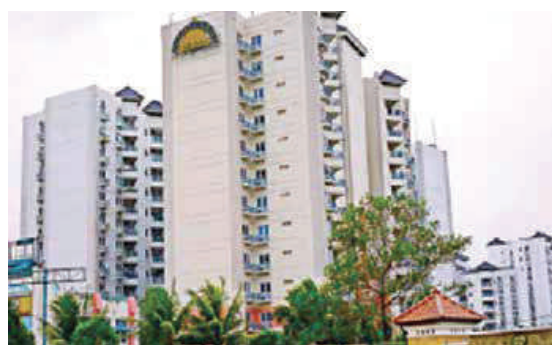
Konominium Menara Kelapa Gading
